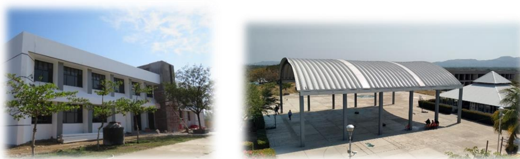
Figura 5. a) Terminación de la Construcción de la Unidad Multifuncional de Talleres y Laboratorios; b) Construcción de domo con un área de 20x24 m2 en la plaza cívica.
