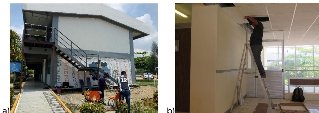
Figura 7. Mantenimiento de sillas; Mantenimiento de aires condicionados
