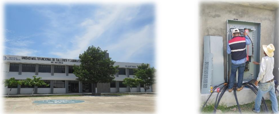
a) b) Figura 3. a) Unidad Multifuncional de Talleres y Laboratorios; y b) Instalación de tablero de distribución de carga
