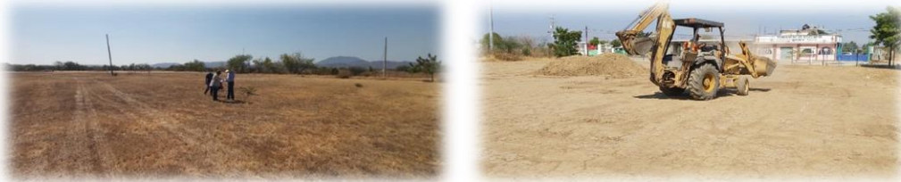
Figura 5. Señalamiento y despalme del área a construir
