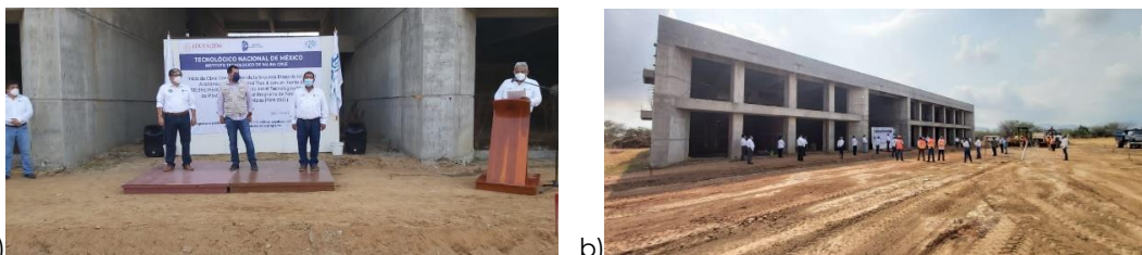
a) b) Figura 4. a) y b) Ceremonia de Banderazo de Segunda Etapa de Construcción de la Unidad Académica Departamental Tipo II
