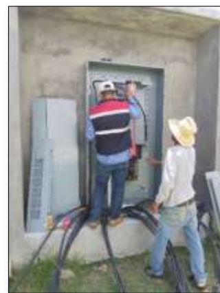
Figura. a) Unidad Multifuncional de Talleres y Laboratorios; y b) Instalación de tablero de distribución de carga
